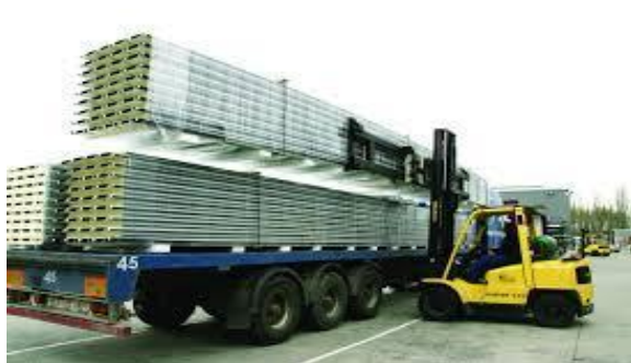
demonstration av lossning av paneler med gaffeltruck)
